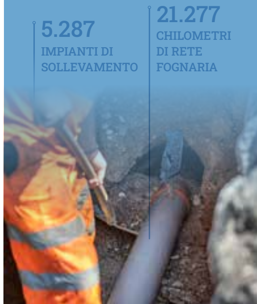
© Viacqua Cantiere separazione reti fognarie Dueville (VI)
