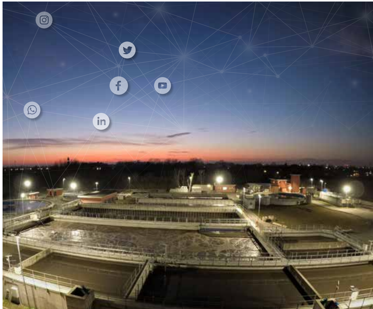
ATS Depuratore di Treviso (TV)
