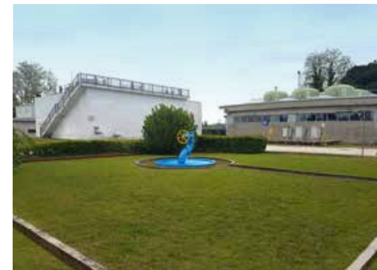
Veritas Impianto potabilizzatore a Cavanella d'Adige, Chioggia (VE)
