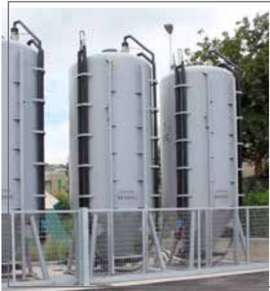
Medio Chiampo Filtrazione anti PFAS a Zermeghedo (VI)
