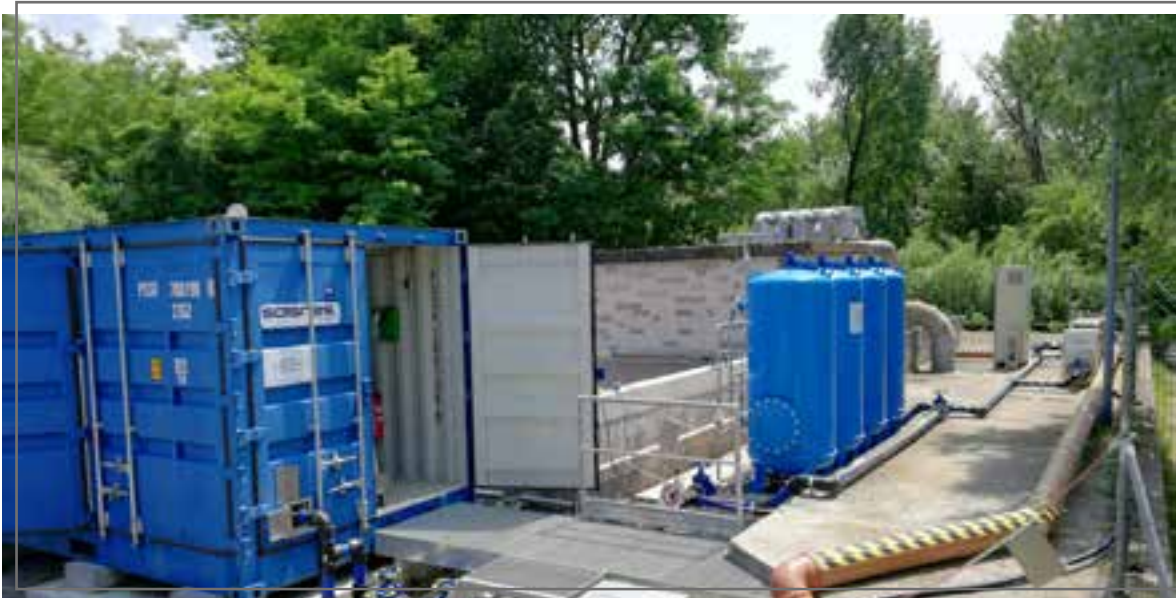
AGS (Progetto europeo INTCATCH) Sistema trattamento sovrafflussi di piena a Lazise (VR)
